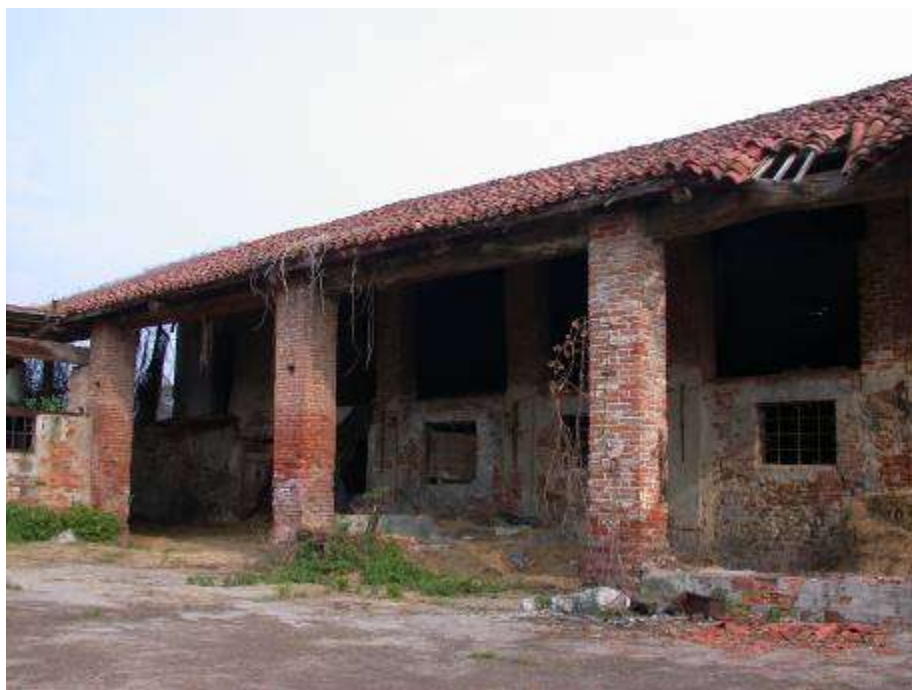
Fotografia (7) – ripresa dal cortile – porzione rustica
